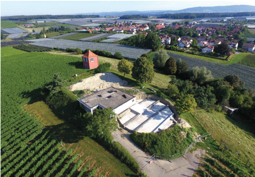
Dachsanierung der kleinen Wasserkammer am Hochbehälter
