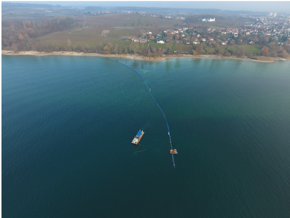
Neue Seewasserentnahmeleitung
