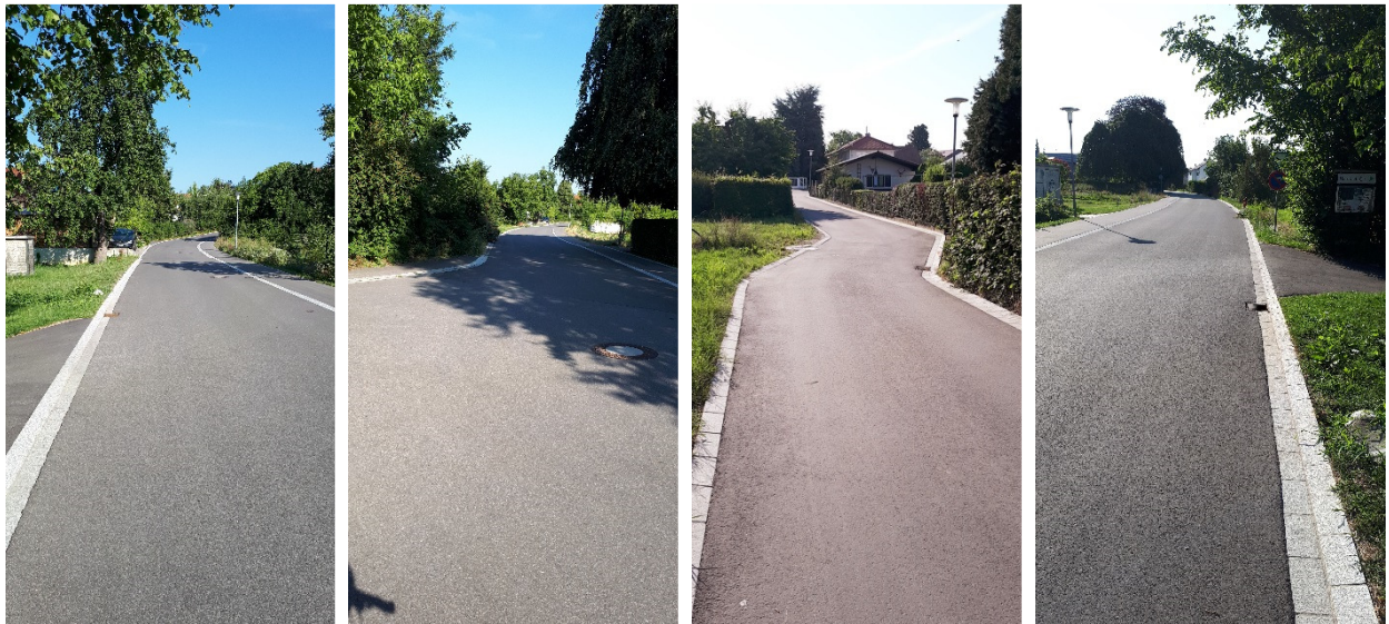
Fertigstellung der Hardtstr. Süd
