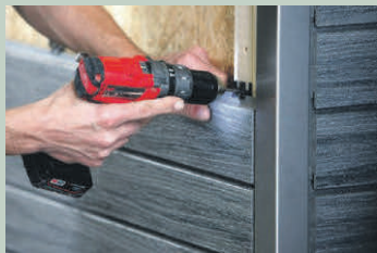
Fassadenprofile werden mit einer Nut- und Spundverbindung formschlüssig auf einer Holzunterkonstruktion angebracht. Foto: djd/NATURinform
