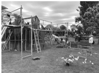
Dachdeckerarbeiten an der Fischerhütte Foto Thomas Schmidt
