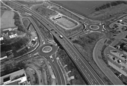
Luftbild von der neuen Anschlussstelle Überlingen-Nord (Abigknoten)
