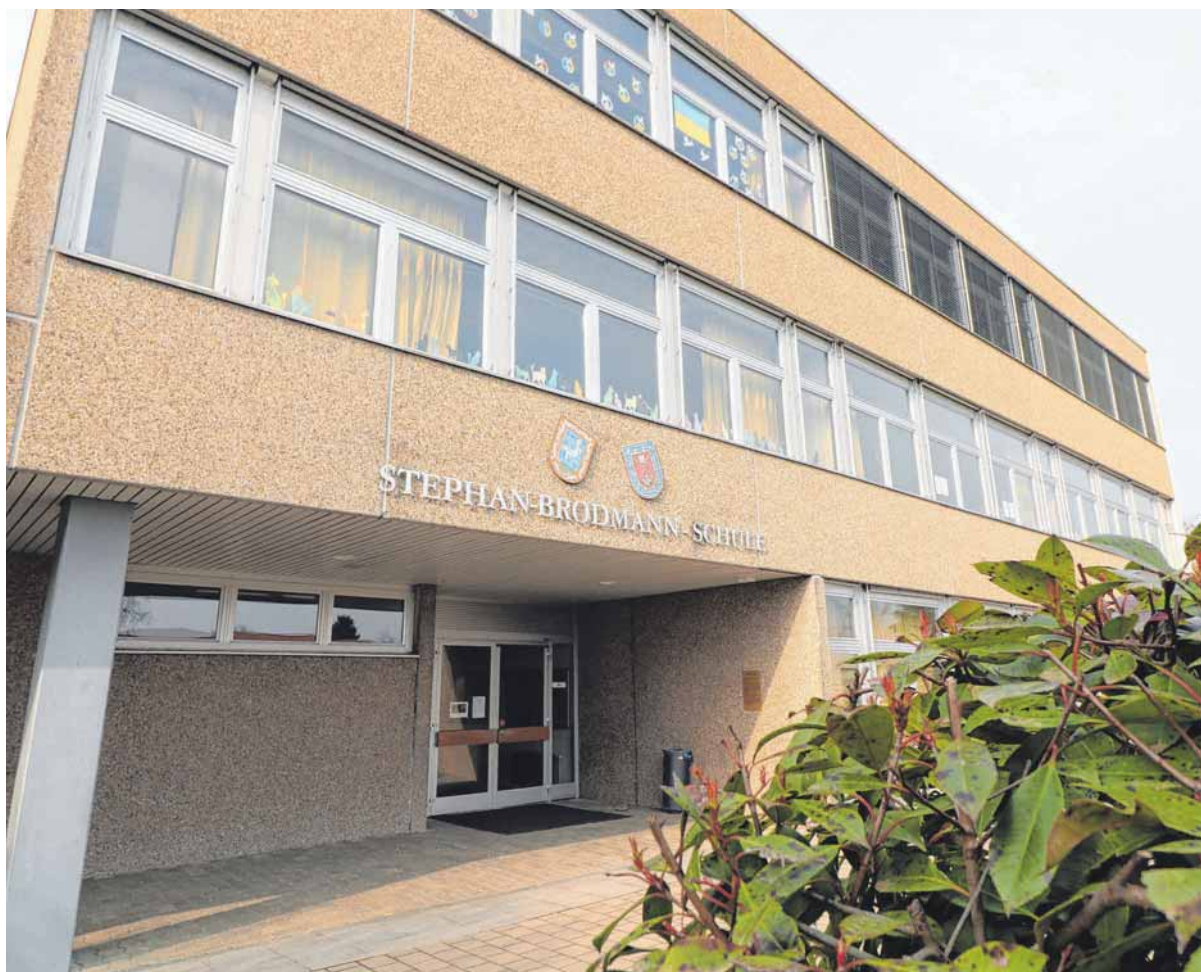
Wird die Gemeinde Immenstaad in den nächsten Jahren einiges kosten: der Umbau der Stephan-Brodman-Schule. FOTO: PEK
