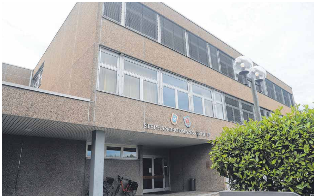
Die Stephan-Brodmann-Schule in Immenstaad wird für über 15 Millionen Euro Baukosten saniert.
