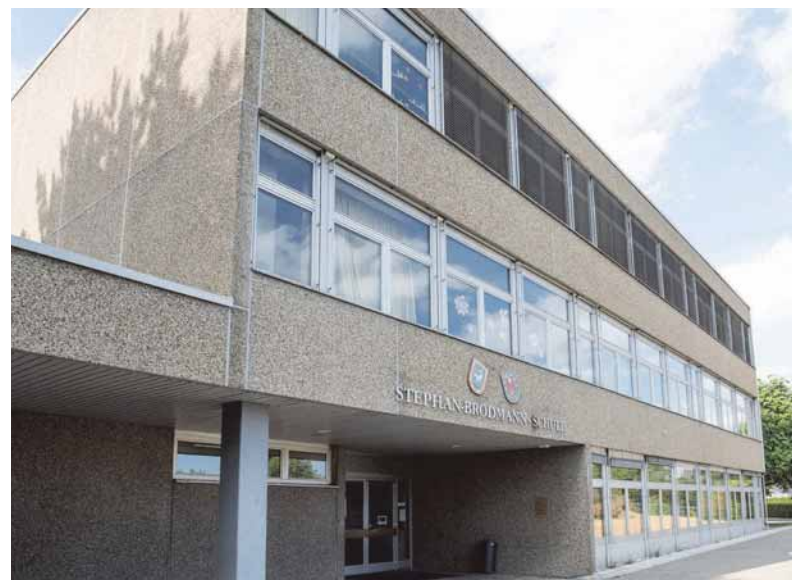
Die aktuelle Fassade der Stephan-Brodmann-Schule, die komplett renoviert werden soll.
